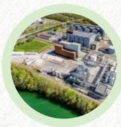
Usine de transformation Le Mériot
